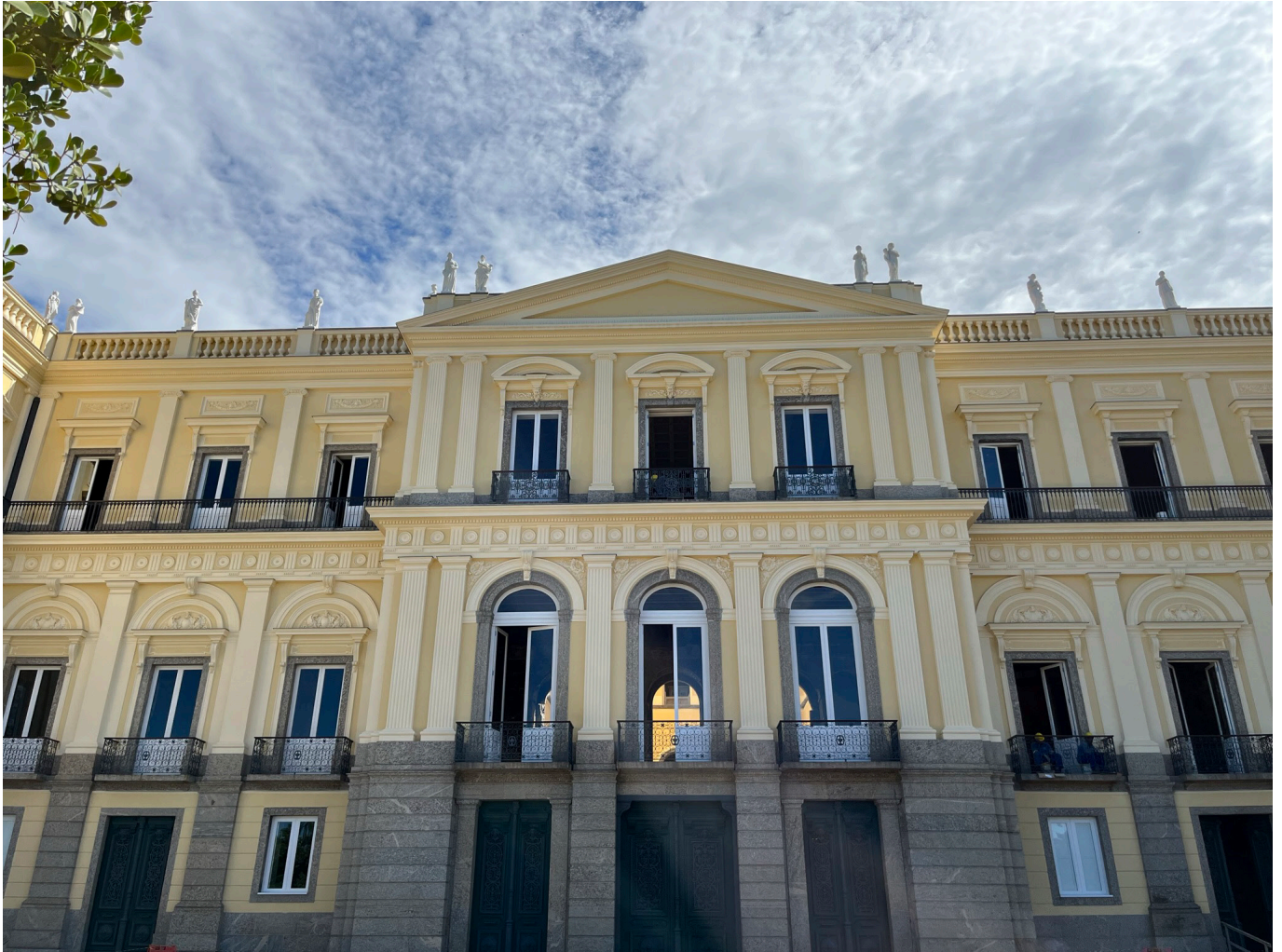
Museu Nacional. Fachada principal restaurada (2023). Fotografia: Vanessa R. Tangerini
