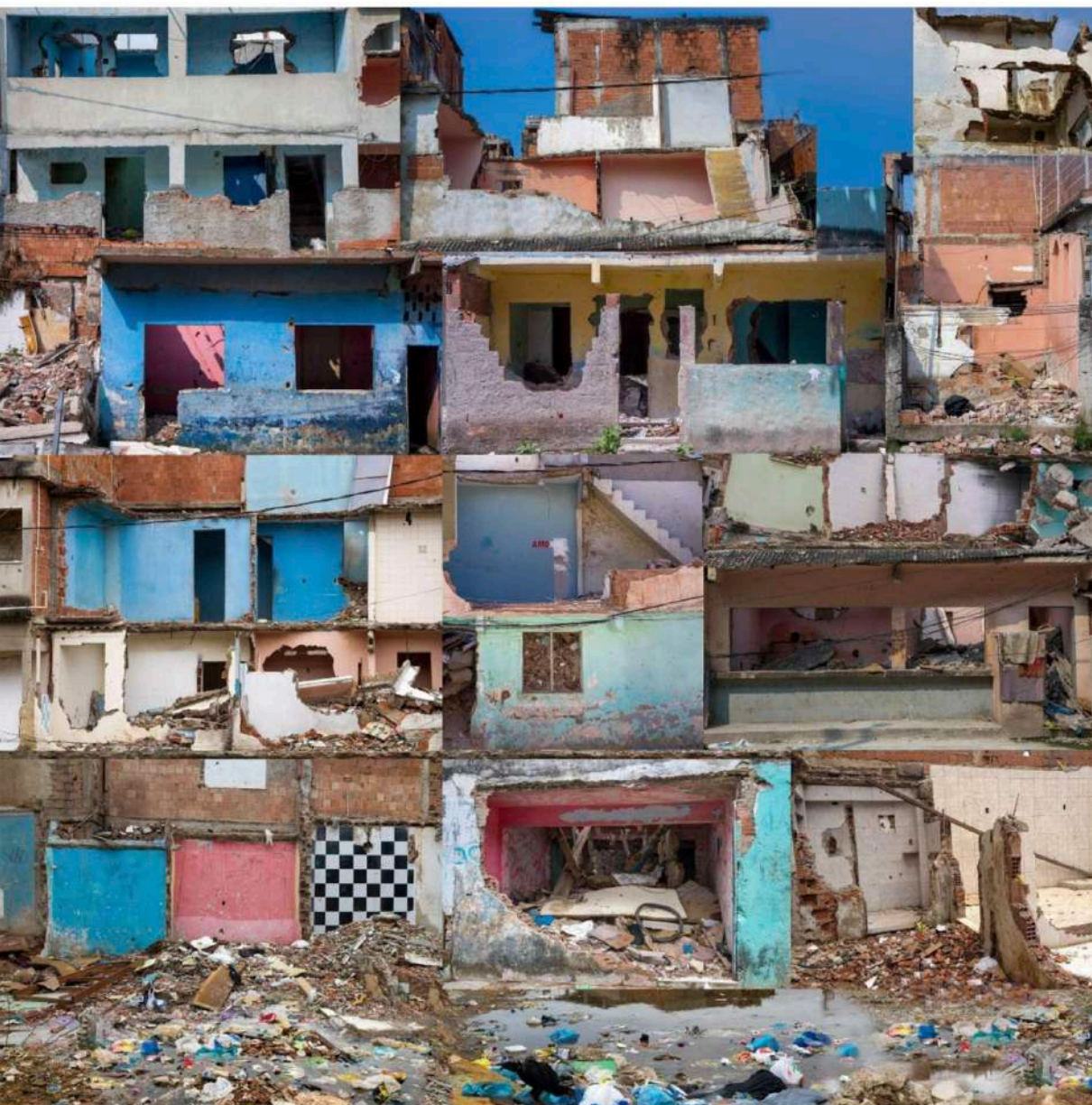
Figura 16: Demolição de casas na favela Beira Rio. Manguinhos, Rio de Janeiro. (Luiz Baltar)
